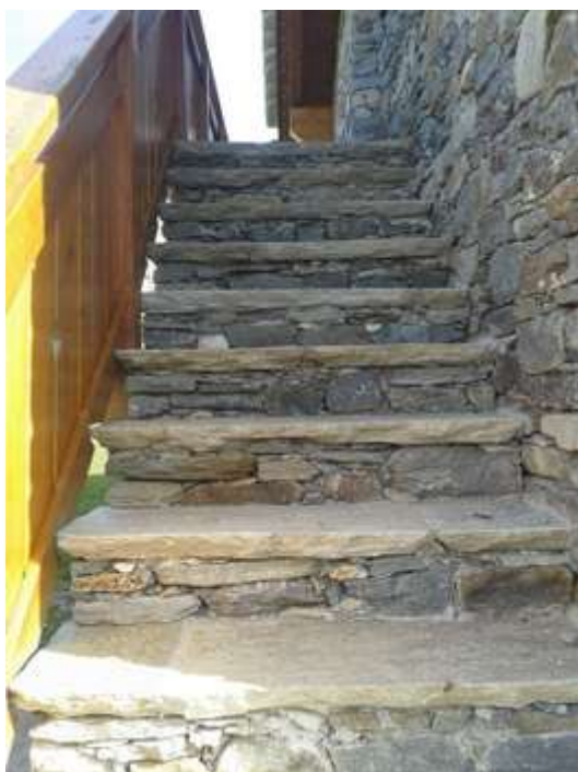
(A sinistra) INTERVENTO DI RECUPERO SCALA CON GRADINI IN BEOLA E ALZATE
