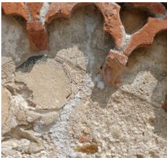
Particolare di facciata prima dell'intervento di integrazione
