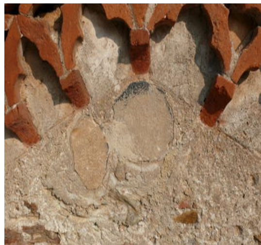
Particolare di facciata dopo l'intervento di integrazione
