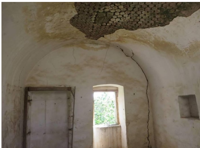
Casolare di campagna particolare di volta a botte.
