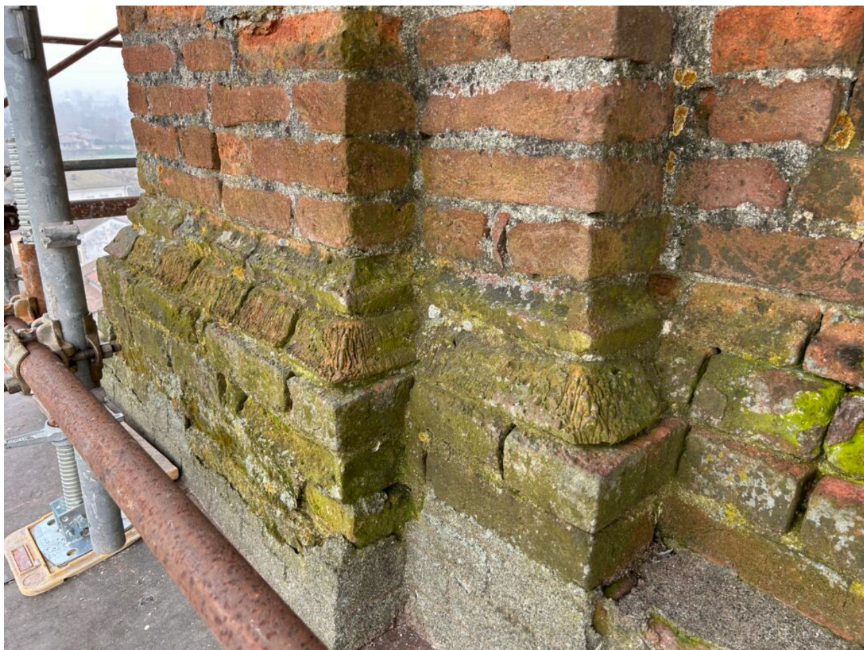
Il campanile di Felizzano
