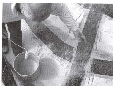
Figura 14. Impregnazione in Kimitech EP-IN.
