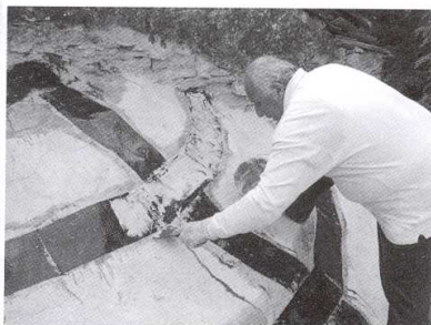
Figura 11. Posa del primo strato di fibra.
