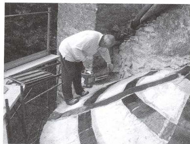
Figura 13. Posa del secondo strato di fibra.
