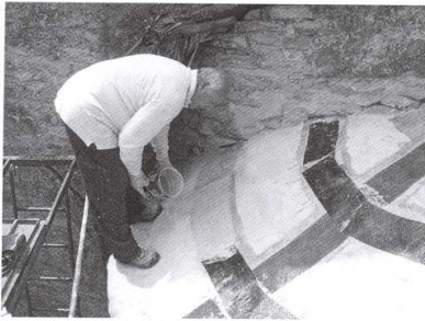
Figura 10. Applicazione Kimitech Primer.
