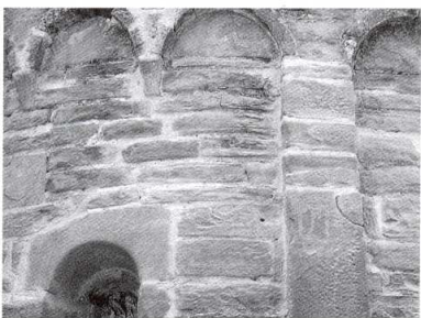
Figura 15. Stilatura dei giunti.
