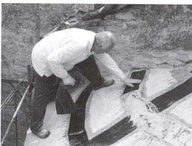
Figura 12. Stesura di stucco Kimitech EP-TX sul primo strato.
