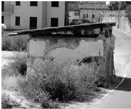
Fig. 4. Veduta d'insieme del fabbricato con arco di Via Delfini.
