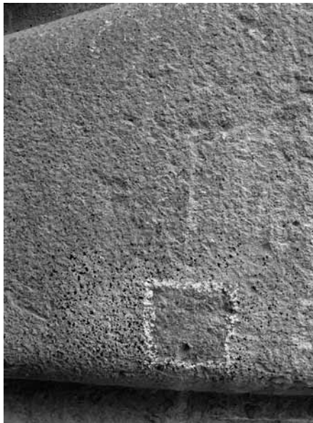
Fig. 16a-b. Particolari delle prove di pulitura eseguite sui conci lapidei dell'arco.
