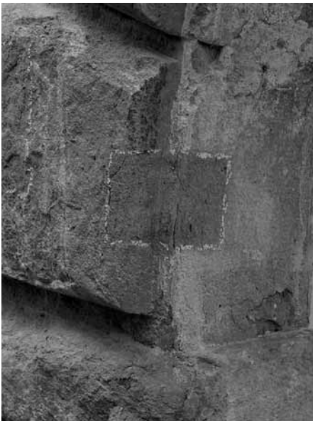
Fig. 16a-b. Particolari delle prove di pulitura eseguite sui conci lapidei dell'arco.
