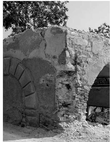
Fig. 13a. Prospetto ovest piedritto sinistro: intervento cuci scuci "prima e dopo".
