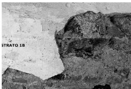
Fig. 11. Particolare dei due strati di intonaco rintracciati internamente.
