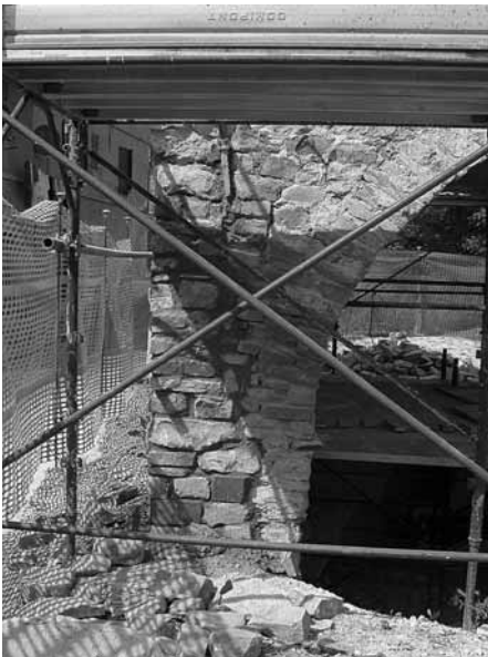
Fig. 13b. Prospetto ovest piedritto sinistro: intervento cuci scuci "prima e dopo".
