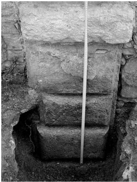
Fig. 10a-b. Scavo ricognitivo: continuità del piedritto sinistro e destro.
