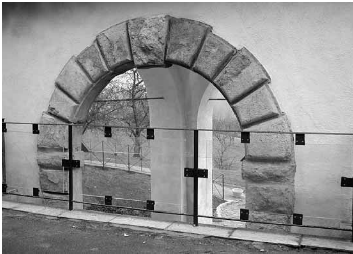
Fig. 17. Particolare esterno del prospetto ovest dopo il restauro.
