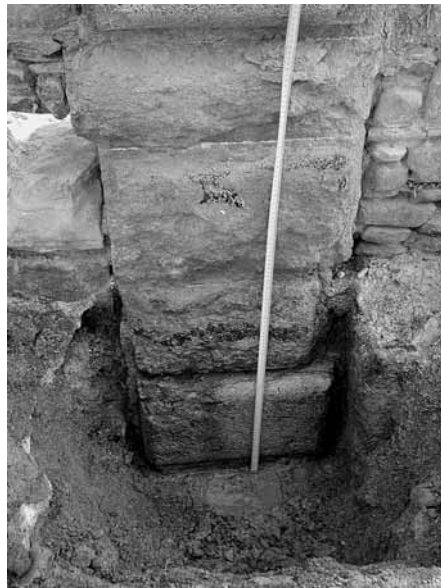
Fig. 10a-b. Scavo ricognitivo: continuità del piedritto sinistro e destro.
