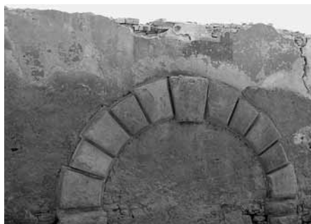
Fig. 5. Particolare del prospetto ovest caratterizzato da un arco in conci di pietra arenaria.
