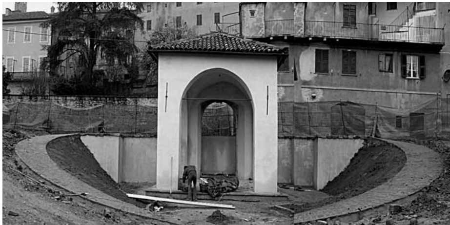
Fig. 15. Veduta d'insieme del quadriportico e delle rampe laterali (lavori ancora in corso).
